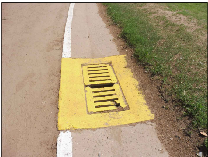
D.21 - CÁMARA DESAGÜE PLUVIAL 1.00x1.20 m
